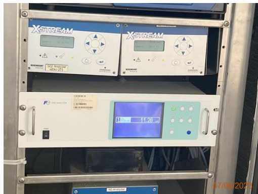
รูปที่ 2-3 ระบบการตรวจวัดคุณภาพอากาศแบบต่อเนื่อง (CEMs)
