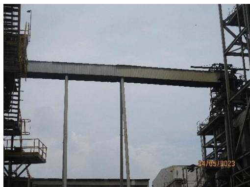
รูปที่ 2-5 สายพานลำเลียงเชื้อเพลิงชีวมวลจากลานกองเชื้อเพลิง
