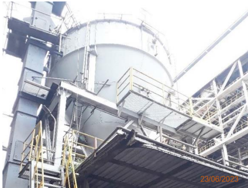
รูปที่ 2-7 ไซโลเก็บเถ้าและสายพานลำเลียง
