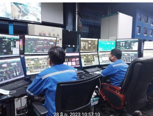
รูปที่ 2-33 ห้องควบคุม (Control Room)
