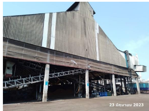
รูปที่ 2-4 อาคารจัดเก็บเชื้อเพลิงชีวมวล NPP5
