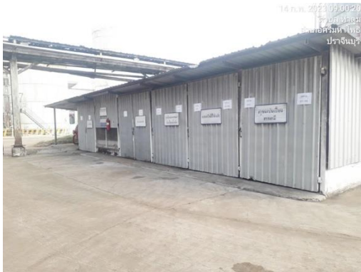
รูปที่ 2-28 พื้นที่รวบรวมน้ำมันที่ใช้แล้ว
