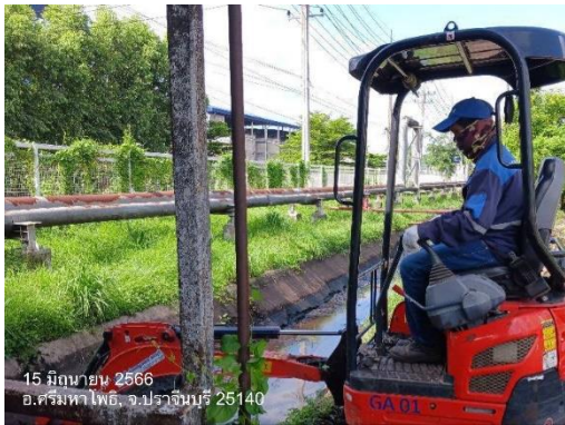
รูปที่ 2-15 การขุดลอกตะกอนรางระบายน้ำ
