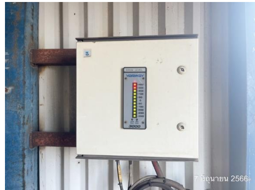
รูปที่ 2-40 มาตรวัดระดับน้ำของหม้อไอน้ำ
