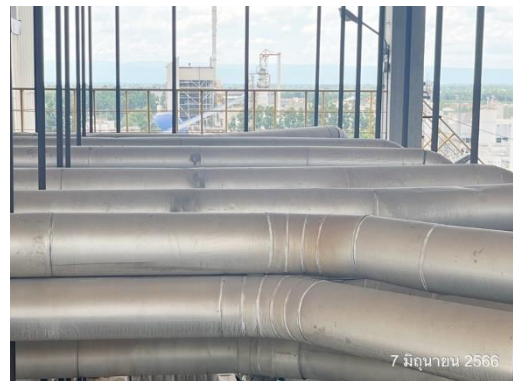
รูปที่ 2-42 ฉนวนหุ้มเปลือกหม้อไอน้ำและระบบท่อ
